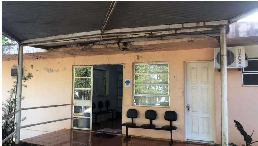
Figura 111: Fachada - entrada (precisa pintura) – porta a vista deve ser retirada
