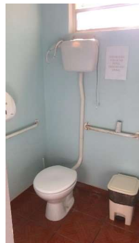
Figura 28: (barras de apoio trocar)
