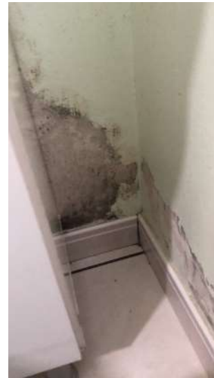
Figura 58: Parede falhas (reboco)
