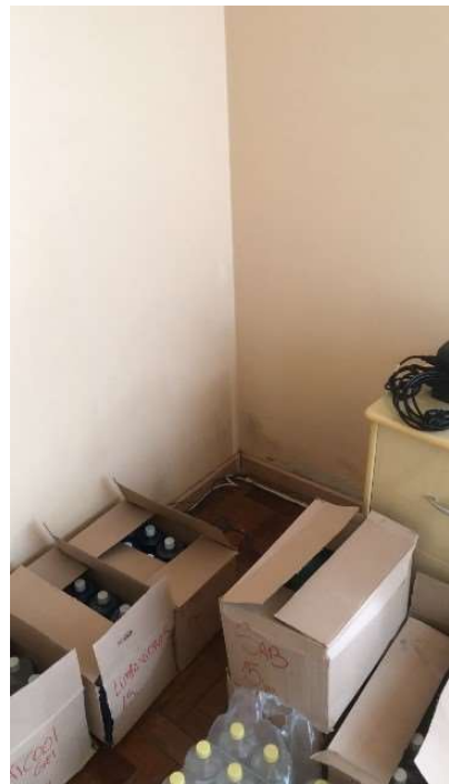
Figura 47: Falhas Parede - sala TO
