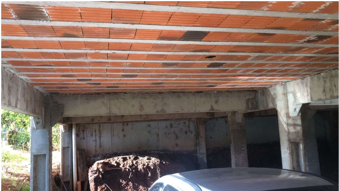
Figura 119: Teto garagem em tijolos
