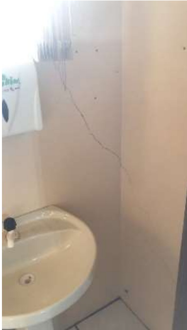
Figura 60: Falha parede - sala triagem
