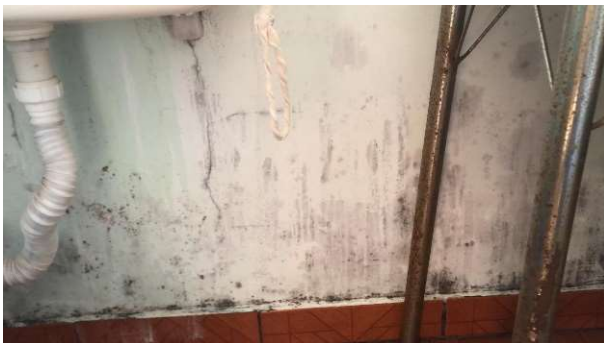
Figura 85: Parede mofa...
