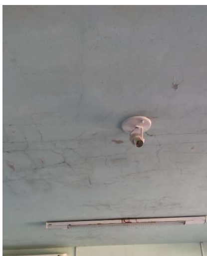
Figura 1: Telhado possui infiltração
