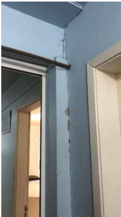
Figura 102: Falhas - pilar parede
