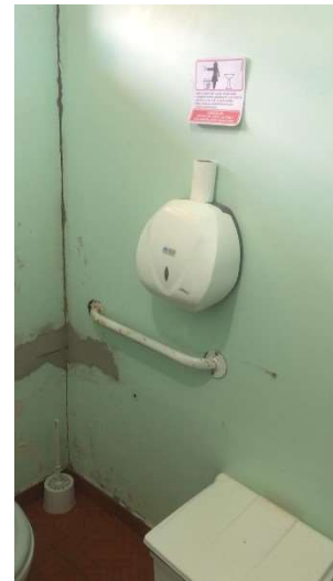
Figura 34: Barras de apoio (trocar)
